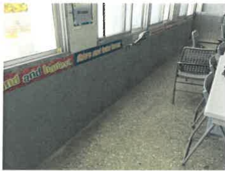
補助第 2、3 項, 英語教室環境建置大圖輸出(85*880CM) 左右牆面各一 施工前
