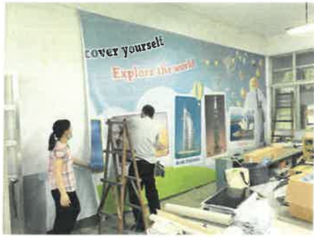
補助第 1 項, 英語教室環境建置大圖輸出(350*720CM 一面) 施工中
